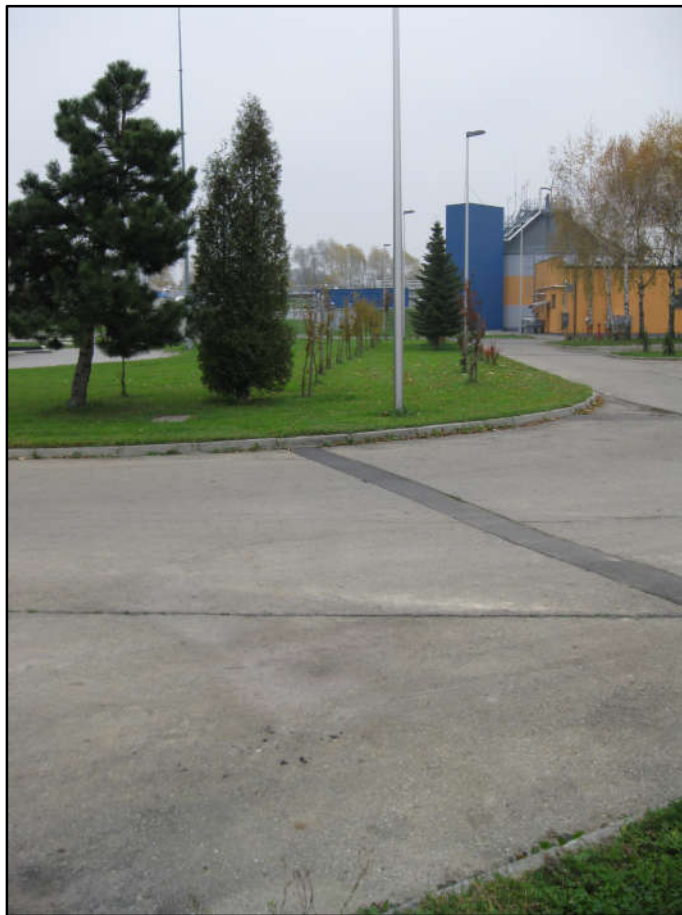
Fot. 9: Przewidywane miejsce wyprowadzenia przyłącza wodociągowego do budynku garażowego (część B budynku).
