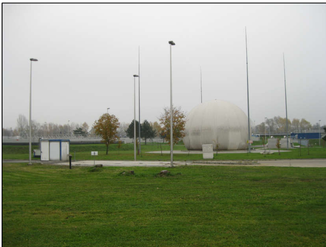
Fot. 10: Istniejące oświetlenie uliczne do przeniesienia.
